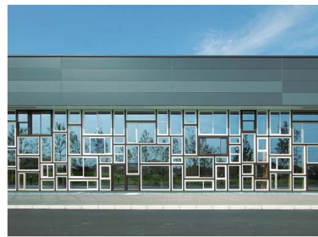
YKK AP 埼玉窓工場
