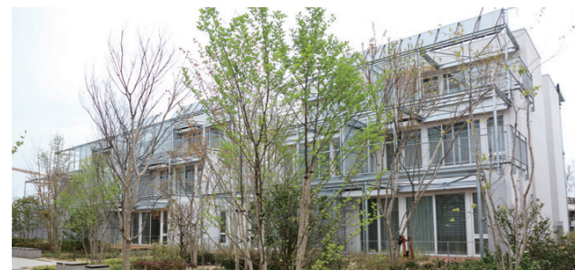
パッシブタウン第1期街区の一角にて。外壁上部に見えるパネルで太陽熱を集めて給湯に利用する
