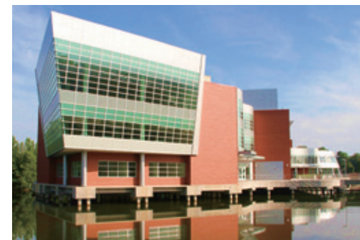
YKK APの高断熱カーテンウォールが採用された教育施設
