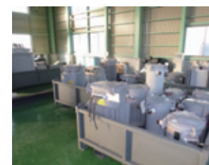
処理した微量PCB含有機器
