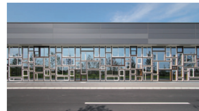
断熱性能に優れた窓「APW330」を約300セット使った埼玉窓工場事務所棟(写真協力：竹中工務店)
