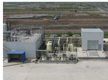
YKK上海社 臨港工場 ファスナーめっき排水の70%を回収し、めっき用水として再利用しています。 (2008年稼働開始)
