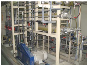
YKK韓国社 ファスナー表面処理排水の98%を回収し、表面処理用水として再利用しています。 (2000年稼働開始) 染色排水の50%を回収し、染色用水として再利用しています。 (2007年稼働開始)
