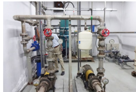
排水診断の様子
