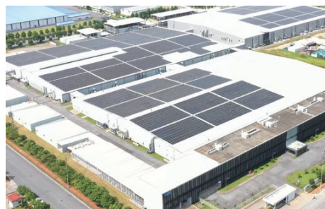
太陽光発電設備写真（YKKベトナム社ハナム工場）
