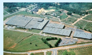
YKK U.S.A.社 メーコン工場
