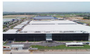
运用了最新系统的新工厂
