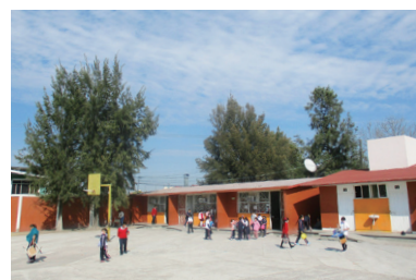
竣工的小学校舍
