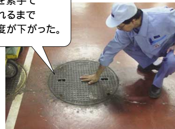
屋内温排水槽(地下)
