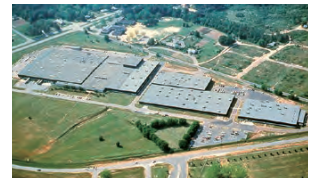
YKK U.S.A.社 メーコン工場
