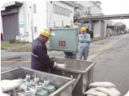
高濃度PCB含有機器搬出作業風景
