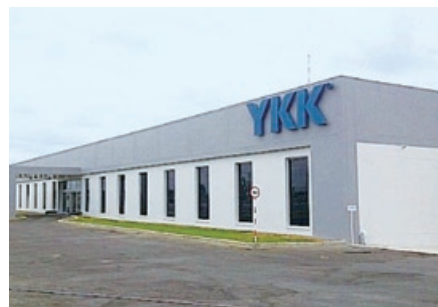
増設が予定されているYKKベトナム社ニヨンチャック工場
