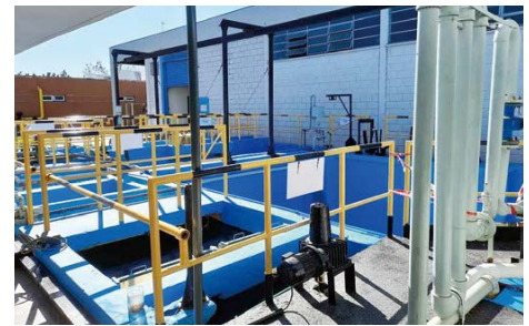
排水診断の様子
