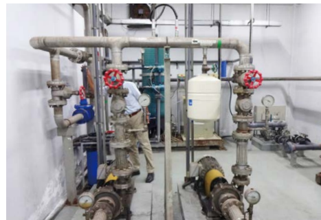
排水診断の様子
