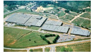
YKK U.S.A.社 メーコン工場
