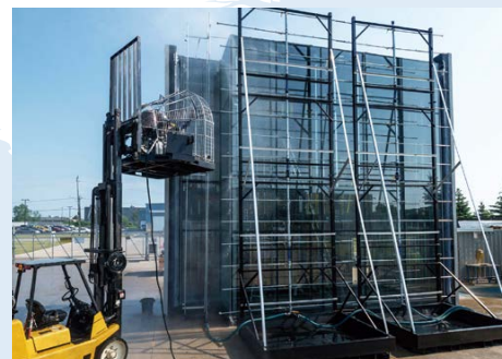
エリー AP社による ユニットカーテンウォール性能検証の様子
