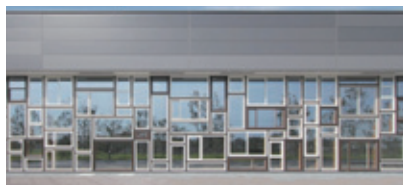
断熱性能に優れた窓「APW330」を約300セット使った事務所棟
