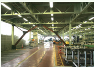
YKK AP四国事業所耐震化工事
