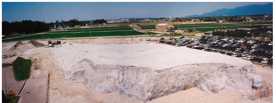
2001年5月 カーバイドスラッジの掘り出し(途中経過)
