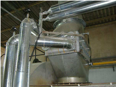
ボイラーの排熱を利用し、ボイラーへの供給水を予備加熱( YKKスペイン社 )
