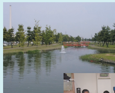
工場排水を利用した水公園
