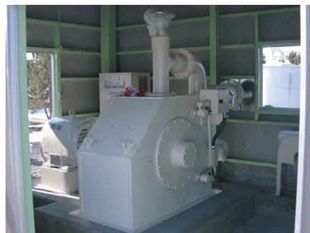
東北工場 工業用水発電装置
