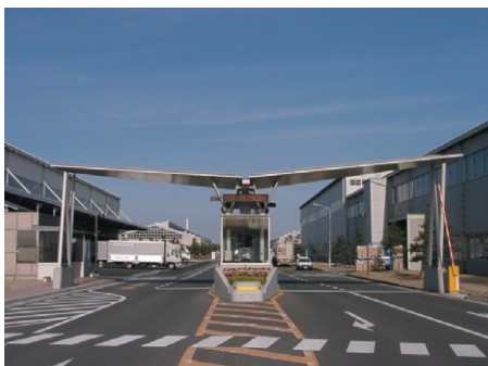
東北工場守衛棟 太陽光発電システム
