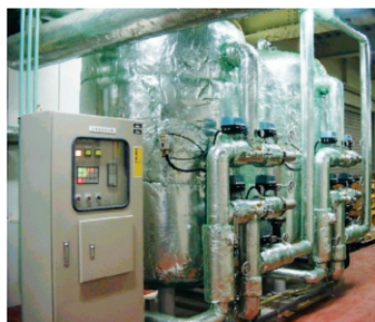
濾過装置導入による工業用水の再利用
