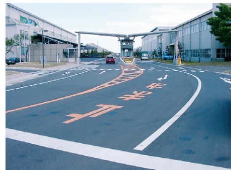
東北工場正門(路盤材に自社ガラス廃材を使用)
