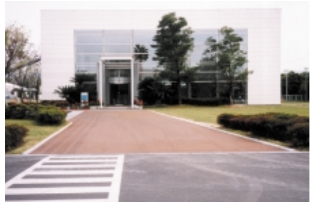
九州工場：ガラス屑を路盤材にして、自社構内に敷設
